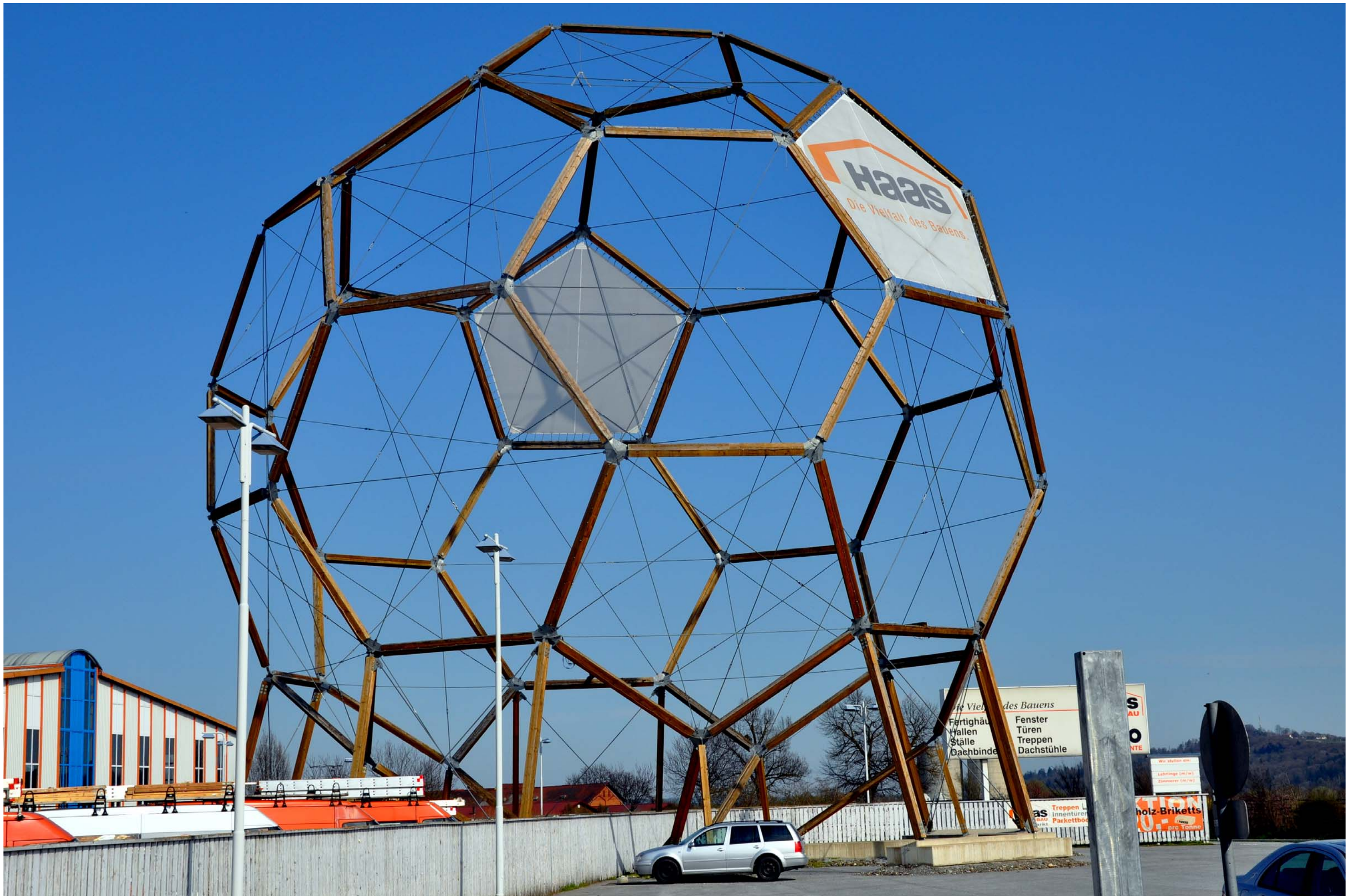
Firma HAAS – HOCO in A-6862 Großwilfersdorf bei Fürstenfeld (Oststeiermark) www.haas-fertigbau.at
